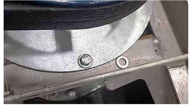
Introducir piezas entre disco y soporte para nivelar las poleas
